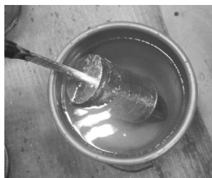
图 16 端头封铅图
